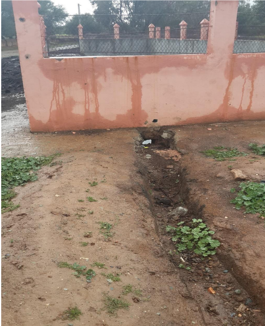
Figure 9 : évacuation du grignon humide vers le bassin via un fossé en terre
